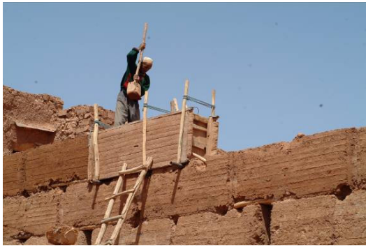
La construction selon le principe de coffrage est une tradition qui s'est perpétuée dans la région des vallées présahariennes depuis des siècles. Ph. BARJALI
