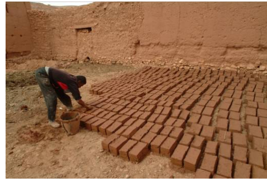
Préparation des briques crues (travaux de restauration du grenier collectif de Tazlaft, oued El Maleh, Ouarzazate Ph. BARJALI
